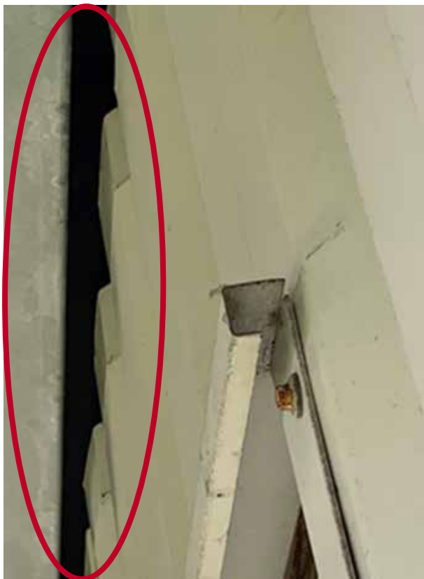
Afbeelding 5.4 Aansluiting tussen dakrand en gevel
