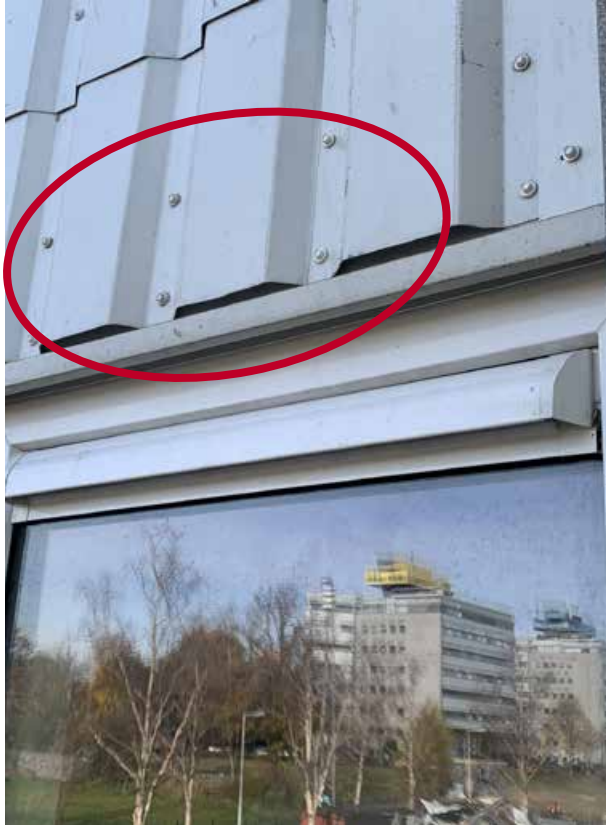
Afbeelding 5.3 Aansluiting gevelbeplating en kunststof raamkozijn
